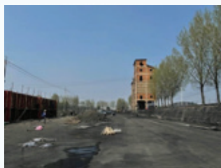
山东凯莱重建围墙工程
