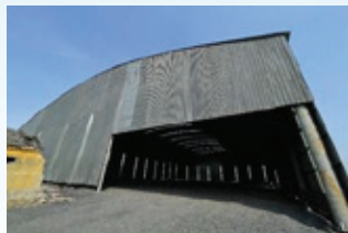
山东凯莱的日常营运情况
